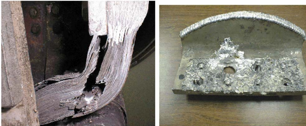
Σχήμα 3.6 Καταστροφή μονωτήρων διέλευσης
