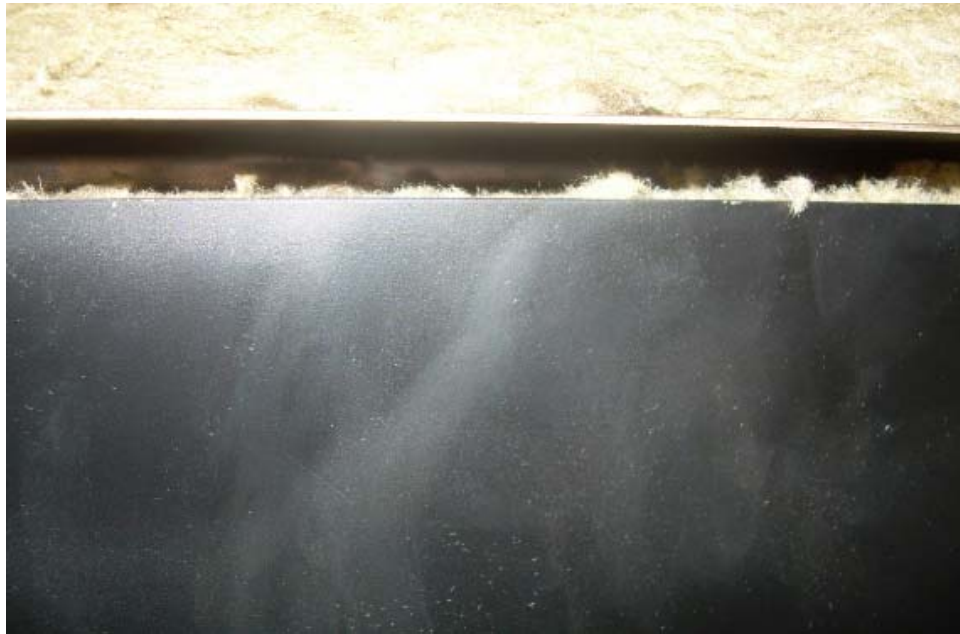
Σχήμα 4.18 Διαστολή λαμαρίνας
