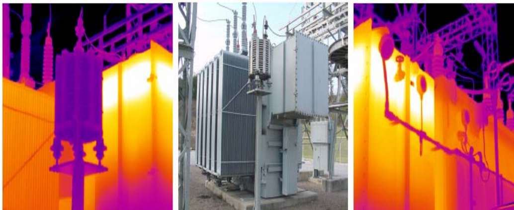
Σχήμα 3.3 Θερμογράμματα και φωτογραφία Μ/Σ
