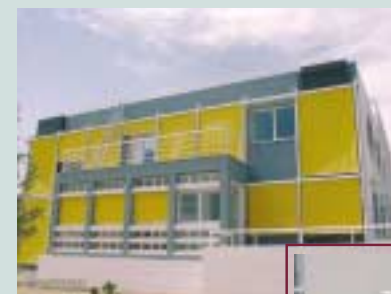
Συστήματα ηλιοπροστασίας της νότιας και ανατολικής όψης του κτιρίου.
