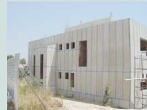
Εξωτερική θερμομόνωση της βόρειας όψης του κτιρίου.
