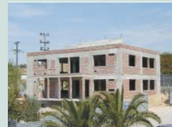
Νοτιοανατολική όψη του κτιρίου κατά την περίοδο κατασκευής των οπτοπλινθοδομών
