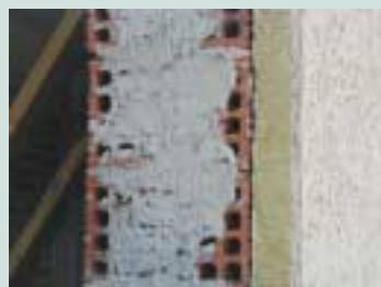
Λεπτομέρεια εξωτερικής οπτοπλινθοδομής με εξωτερική θερμομόνωση
