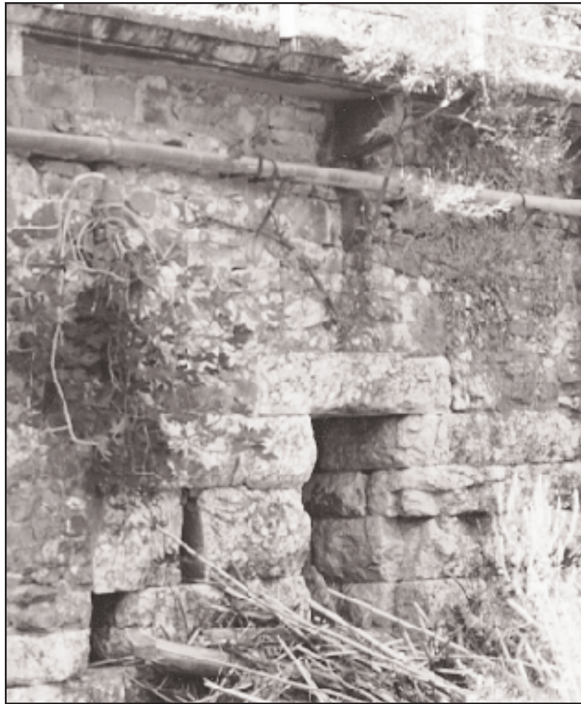
Ενα από τα πολλά ανοίγματα της αρχαίας (3ου π.Χ. αι.) γέφυρας της Βαλύρας (άνω Πάμισος) όπως υπερυψώθηκε και χρησιμοποιείται μέχρι σήμερα (φωτ.: Γ. Γ. Μακρή).
