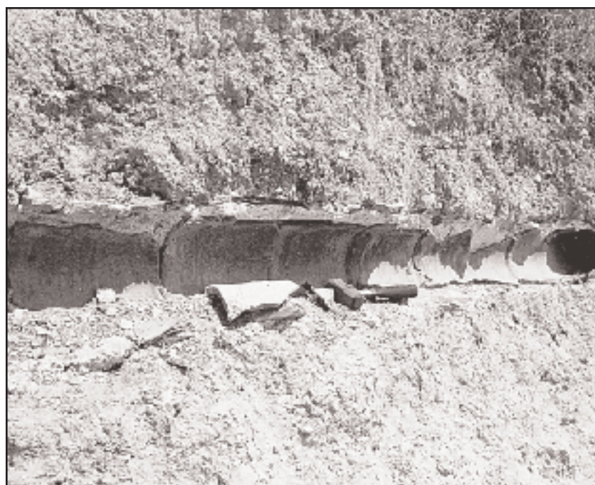
Το τούνελ του κανάτ Νέας Ζίχνης με μήκος μεγαλύτερο από 1.000 μ. Το νερό από το τούνελ οδηγείτο μέχρι το 1980 στους κυλινδρικού σχήματος πήλινους αγωγούς και από αυτούς σε βρύσες που ύδρευαν την κωμόπολη Νέας Ζίχνης. Μετά το 1980, οι αγωγοί αντικαταστάθηκαν με σύγχρονους πλαστικούς.
