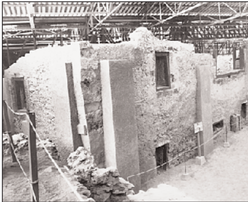
Η Δυτική Οικία στο Ακρωτήρι της Θήρας: κτίστηκε πριν από 3.500 χρόνια και διατηρήθηκε σε άριστη κατάσταση ως τις μέρες μας χάρη στις ηφαιστειακές στάχτες που κάλυψαν τον οικισμό.
