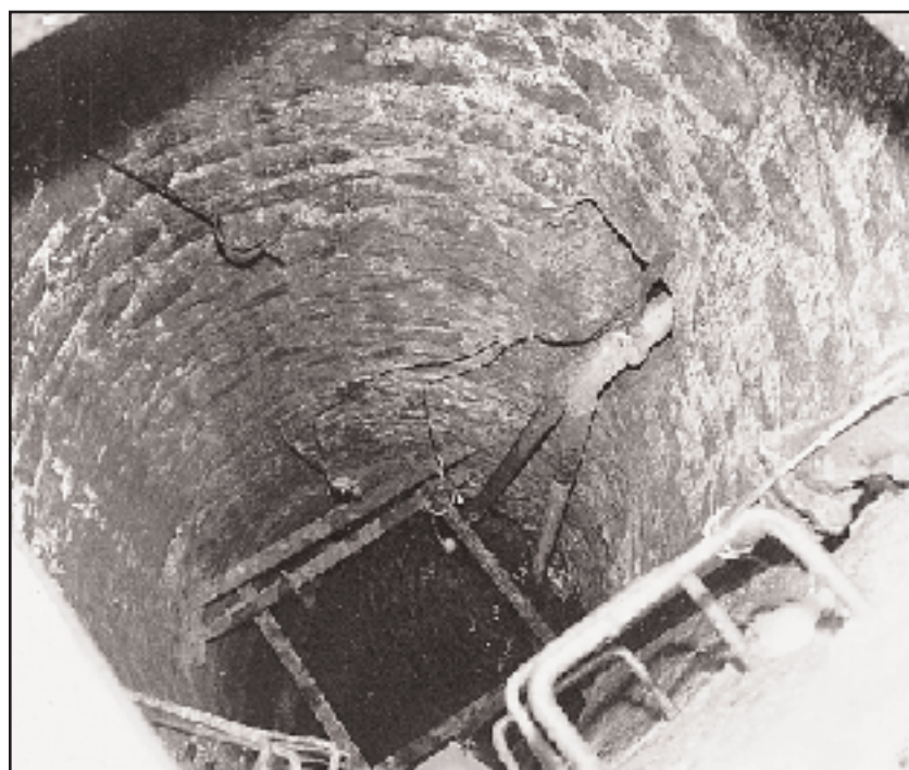
Το πηγάδι της φωτογραφίας ανήκει σ' ένα από τα κανάτ του Σιδ. Σταθμού Αγγίστας Σερρών, που κάλυπτε τις ανάγκες σε νερό των ατμομηχανών μέχρι το 1935. Σήμερα, το πηγάδι καλύπτει τις ανάγκες ύδρευσης του ομώνυμου χωριού.
