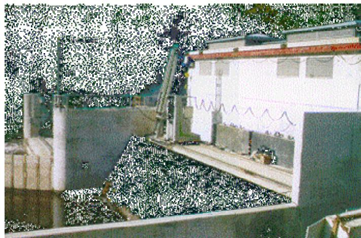
**Σχήμα 1.9. Μηχανικό χτένι στο στόμιο εισόδου ενός μικρού υδροηλεκτρικού**
