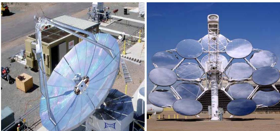
**Σχήμα 4.11. Φωτογραφίες από συστήματα δίσκου/Stirling**
