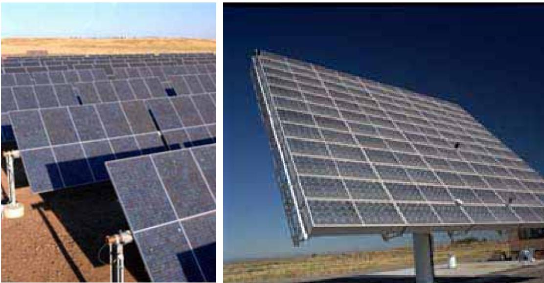
**Σχήμα 3.14. Παρακολούθηση τροχιάς μονού άξονα (αριστερά) και συγκεντρωτικές κυψέλες με παρακολούθηση τροχιάς διπλού άξονα (δεξιά)**
