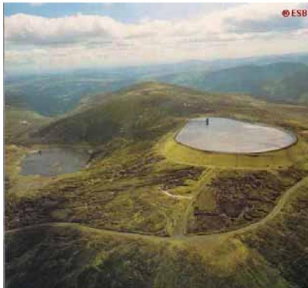
**Σχήμα 7.2. Εναέρια άποψη των άνω και κάτω ταμιευτήρων της εγκατάστασης αποθήκευσης με άντληση στο Turlough Hill (Ιρλανδία)**
