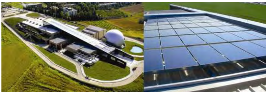
Ενσωμάτωση άμορφων φωτοβολταϊκών στο Τεχνολογικό Μουσείο Θεσσαλονίκης
