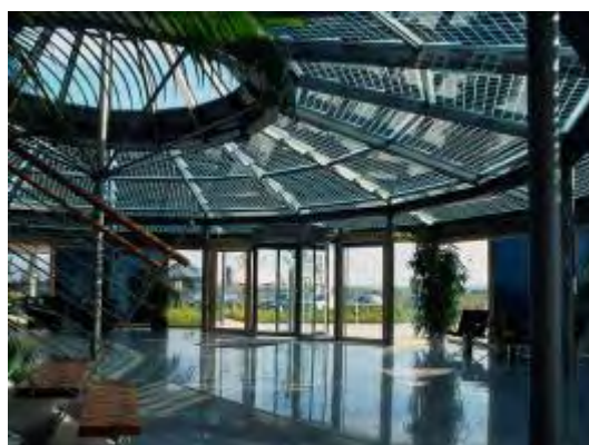
Εφαρμογή φωτοβολταϊκών που επιτρέπουν τη διέλευση φυσικού φωτός σε εμπορικό κτίριο
