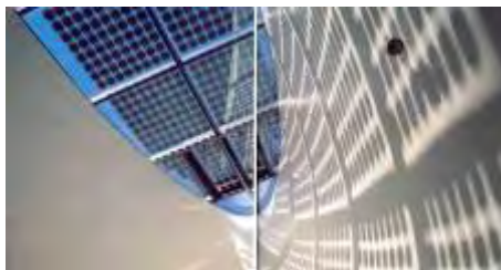
Φουτουριστικό αποτέλεσμα από εφαρμογή φωτοβολταϊκών ως skylight σε σχολείο της Δανίας
