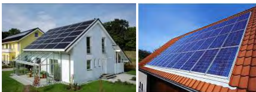
Ενσωμάτωση φωτοβολταϊκών σε στέγες κτιρίων
