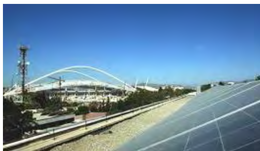
Εφαρμογή φωτοβολταϊκών στη στέγη της Γερμανικής Σχολής στο Μαρούσι
