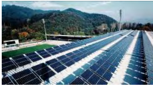
Ενσωμάτωση φωτοβολταϊκών σε γήπεδο ποδοσφαίρου
