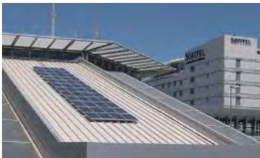
Ενσωμάτωση φωτοβολταϊκών στο σταθμό του μετρό στο αεροδρόμιο Ελευθέριος Βενιζέλος
