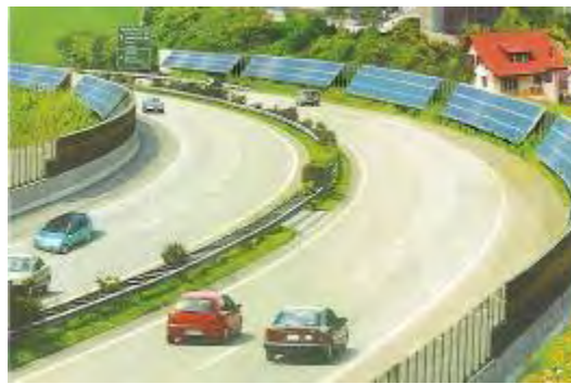
Εφαρμογή φωτοβολταϊκών σε ρόλο ηχοφράγματος σε αυτοκινητοδρόμους
