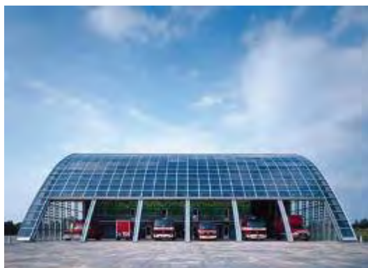
Ενσωμάτωση φωτοβολταϊκών σε πυροσβεστικό σταθμό
