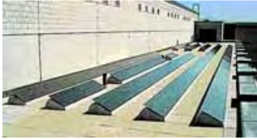
Εφαρμογή φωτοβολταϊκών σε τσάρα κτιρίου
